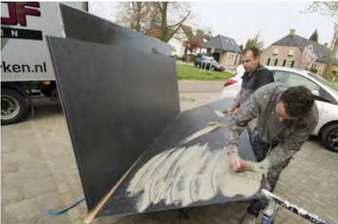
04 Gluing of the slab 04 Encolado de la tabla
