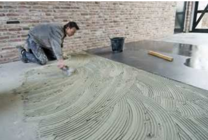
06 Doble-gluing of the flooring 06 Doble encolado de la solera
